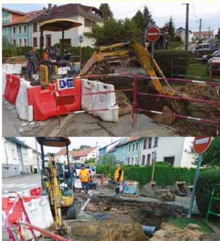
Début des travaux rue de la paix
